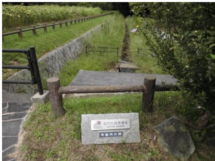
長尺りからの注入口
