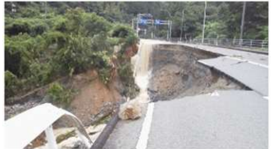
(写真は山口県国道191号線の被害の様子 萩市ホームページより)
