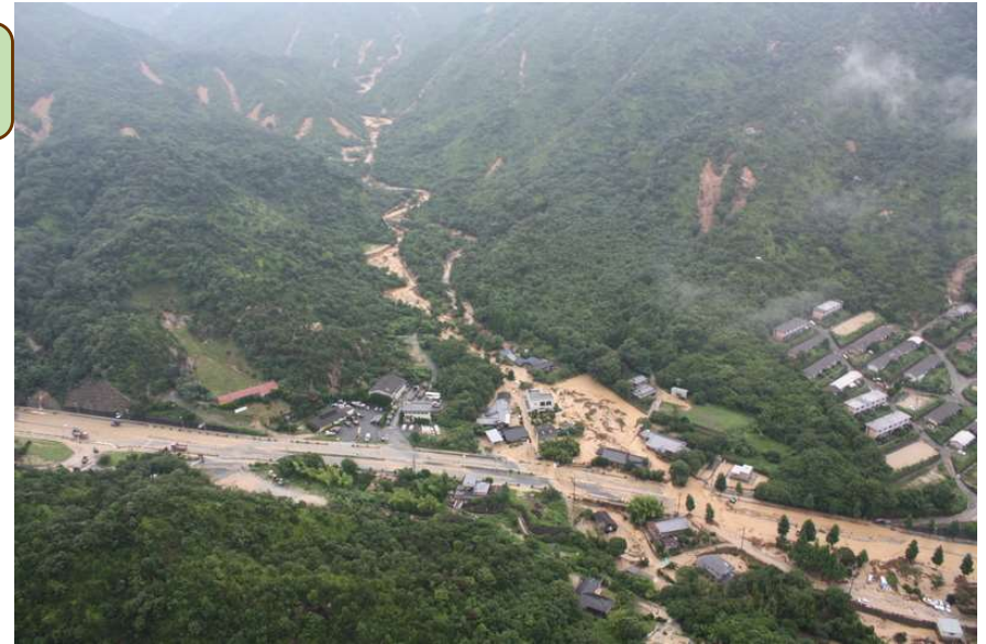
(写真は山口県国道262号線の被害の様子 山口県ホームページより)
